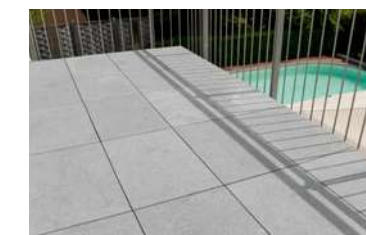
... die Platten immer im rechten Winkel und fluchtgerecht verlegt werden. So erhalten Sie eine stabile Fläche und ein gleichmäßiges Fugenbild.
