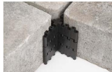
Dès que quatre pavés forment un joint en croix, on insère le croisillon dans le joint. Sur les bords et entre elles, les dalles doivent être posées serrées. En pleine surface aussi, les pavés ne doivent pas avoir de jeu et l'écart entre eux doit se limiter aux croisillons. La pose d'une bordure ou similaire comme fixation de bordure est indispensable.
