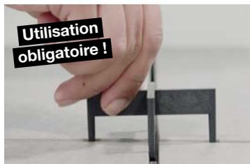
Dès qu'une dalle est posée sur un quart de plot, insérez le croisillon dans le joint par le haut pour servir de bloqueur de roues dentées.
