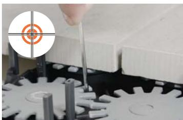
Vous pouvez effectuer le réglage fin de la hauteur de dalle en tournant les roues de réglage avec une tige de fer. Comme les roues dentées font saillie dans le joint, vous pouvez même régler la hauteur lorsque la dalle est déjà placée.
