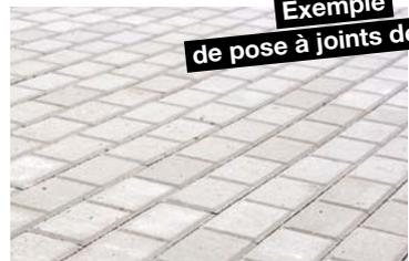
Si vous veillez toujours à poser les guides de joint de manière très serrée, vous obtiendrez un tracé de joint propre et une surface stable. Le dallage ne subit ni dégâts dus au gel, ni efflorescences, car il n'y a pas de joint de mortier dégageant du calcaire ou du ciment.
