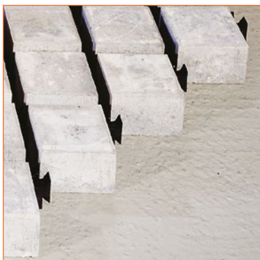
Pokládka křížků pro zatravňovací spáry
