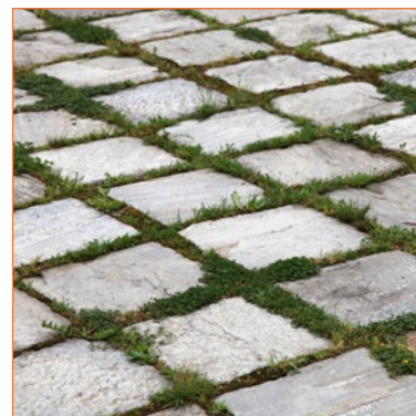
Příklad pokládky křížků pro zatravňovací spáry u dlažby s křížovou vazbou
