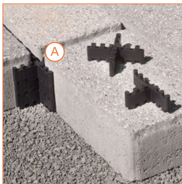
Pose de croisillons en T
