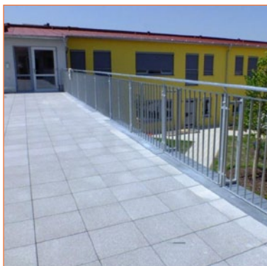
Maison de retraite de Burgbernheim Toit-terrasse
