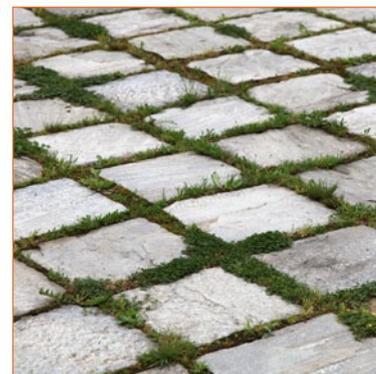
Exemple de pose de croisillons pour joints engazonnés, dalles posées à joints alignés
