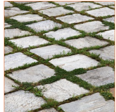
Legvoorbeeld grasvoegkruisjes in volsteensverband met klinkers
